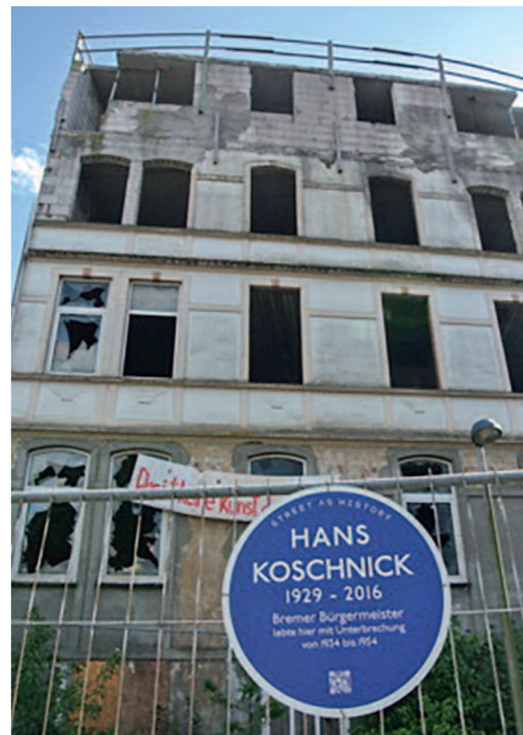
Nur noch eine Ruine: Das Koschnick-Haus Foto: Archiv
