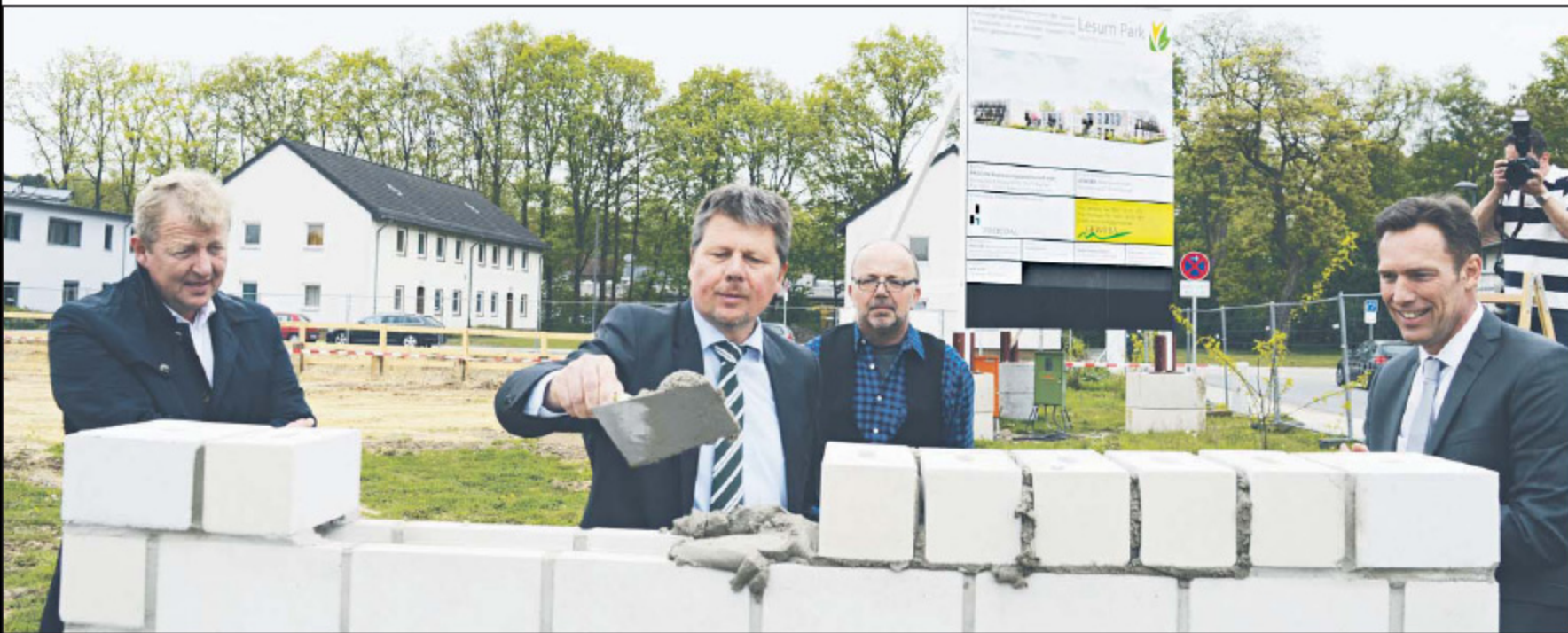
Gestern wurde der Grundstein für ein weiteres Wohnungsbauprojekt im Lesum-Park gelegt. Das Foto zeigt GEWOBA-Vorstand Peter Stubbe, Bausenator Dr. Joachim Lohse und PROCON-Geschäftsführer Thorsten Nagel (vorne von links)
